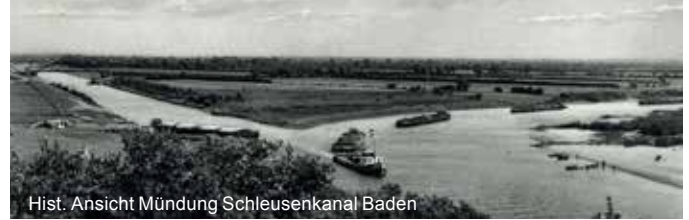
Hist. Ansicht Mündung Schleusenkanal Baden
