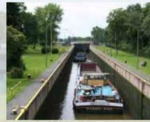
Schleuse: Nutzbare Länge: 221,00 m, Nutzbare Breite: 12,30 m, max. Hubhöhe: 5,50 m, Schleusenkanal Länge: 2,22 km, Baujahr: 1959 -1960, UKW – Funkkanal: 27
